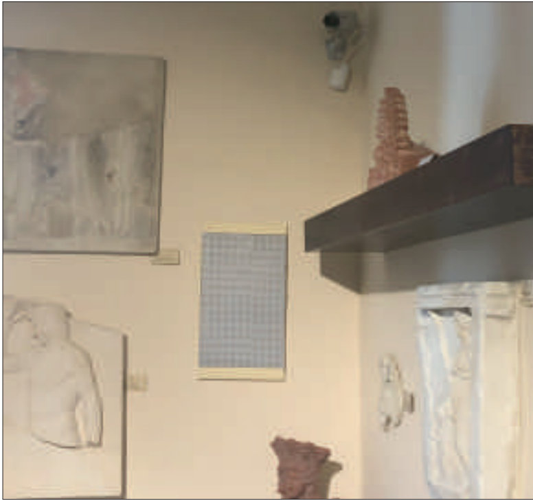
Abbildung 2: Der Bewegungsmelder (oben im Bild) war nicht stabil genug befestigt und konnte vom Täter problemlos in der Ausrichtung verändert werden, wodurch er in Richtung Decke zeigte und nutzlos geworden war (Foto: Sascha Puppel)
